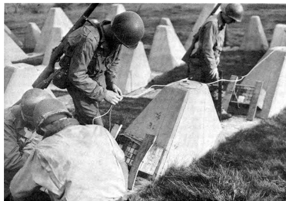
8. Kép: Sárkányfog hatásfokának növelése robbanó töltetekkel [20]
