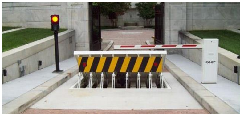
11. Kép: Vegyesen alkalmazott járműakadályok őrzött állapotban [36]
