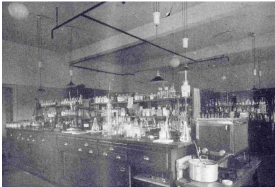
8. ábra: Olvadórózsákkal ellátott oltórendszer elhelyezése vegyi laboratóriumban [18]
